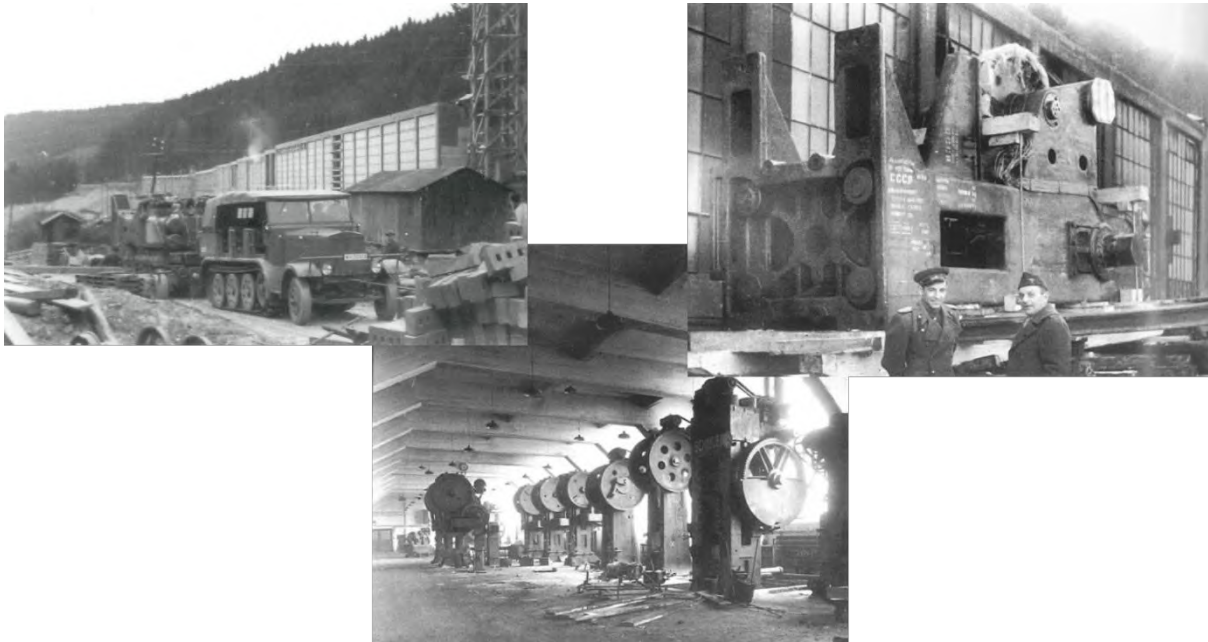
Abb. 19: Anlieferung der Pressen, Hallen nach Kriegsende, Demontage und Abtransport in die UdSSR (von links nach rechts) [6]
